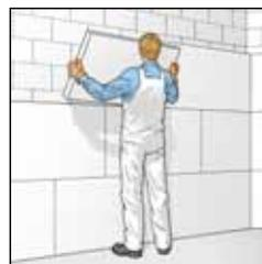
**7.** Klimaplatte übereinander versetzt mit mäßigem Druck an die Wand anpressen. Kreuzfugen und Lücken vermeiden. Überschüssigen Kleber an den Rändern entfernen.
